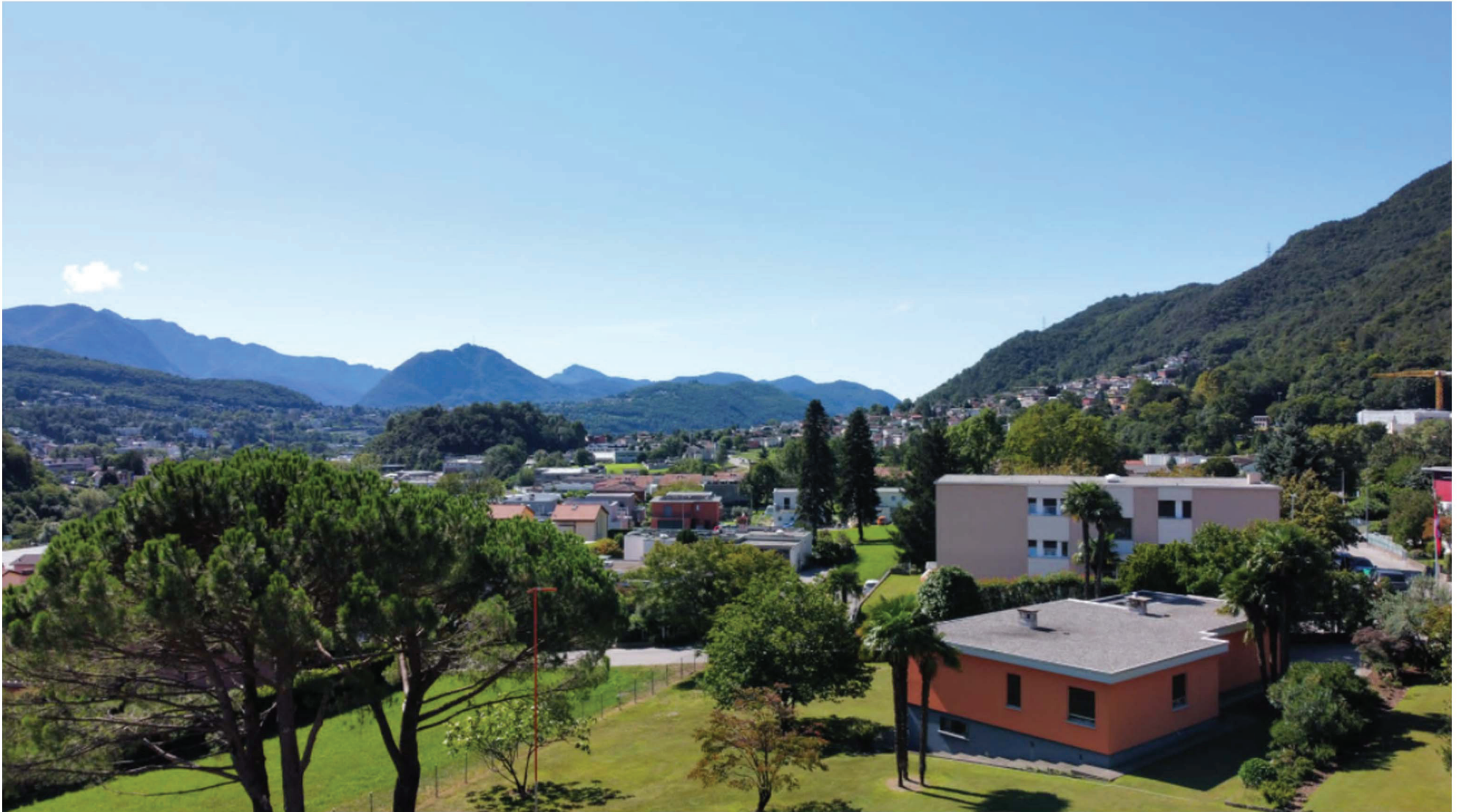
VISTA 2 PIANO LATO SUD
